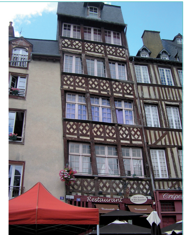
L'architecture à pans de bois. À l'image de ce bâtiment situé place du Champ-Jacquet, est typique du centre ancien de Rennes. Elle indique que les secteurs que l'incendie de 1720 a épargné.
